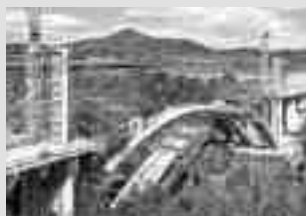
Coffrage de Pont
