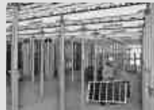
Coffrage de Dalle
