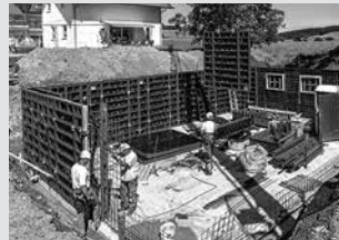
Coffrage de mur
