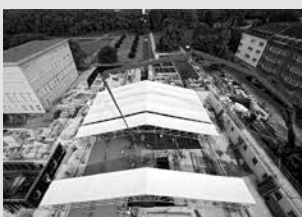
Échafaudage de protection
