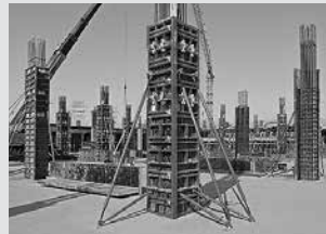
Coffrage de colonnes
