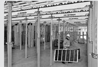
Coffrage de dalle
