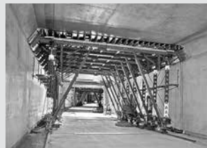
Coffrage de tunnel
