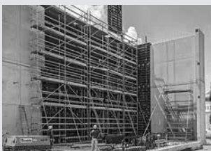
Échafaudage de chantier
