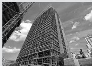
Échafaudage de façade
