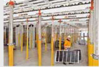
Coffrage de dalles
