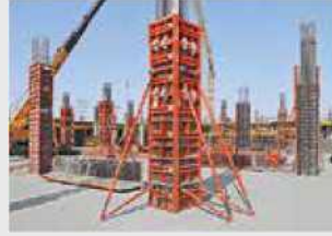
Coffrage de colonnes
