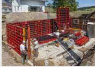
Coffrage de mur
