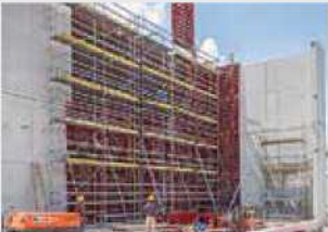
Échafaudage de construction
