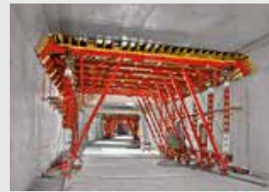
Coffrage de tunnel
