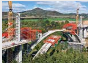
Coffrage de pont
